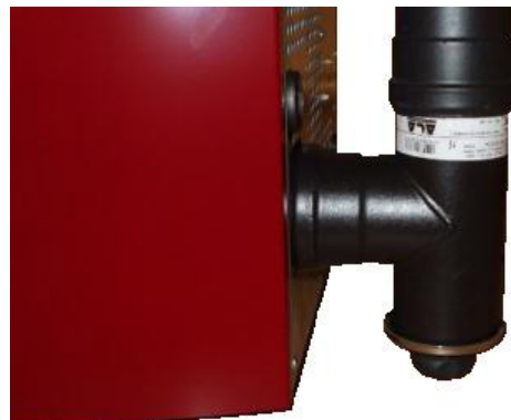
Fig. 34 - Fume conduit cleaning
