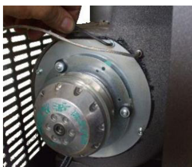
Fig. 35 - Reiniging rookgassenafzuiger: fase 1
