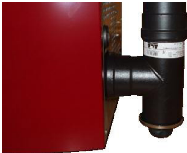
Fig. 34 - Nettoyage du collecteur des fumées
