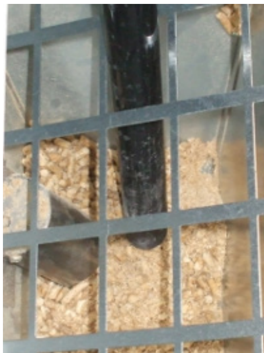
Fig. 31 - Limpieza depósito y coclea
