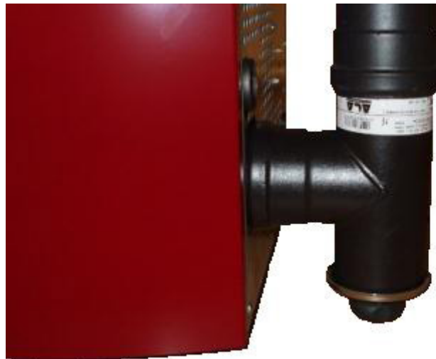
Fig. 34 - Limpieza canal de humos
