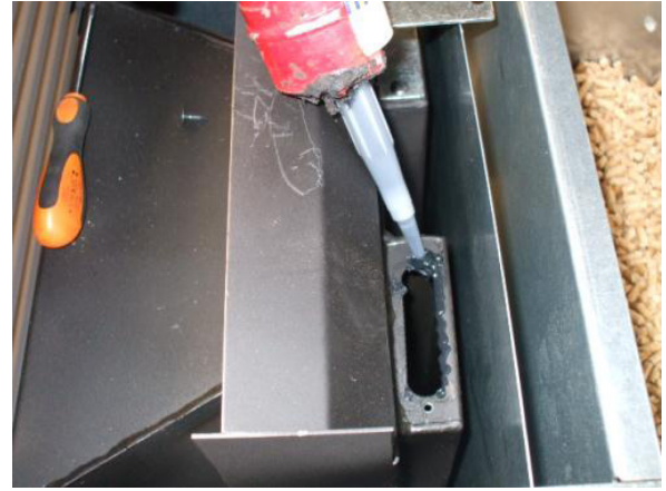
Fig. 41 - Colocación de la silicona
