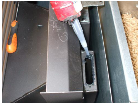
Fig. 41 - Τοποθέτηση σιλικόνης
