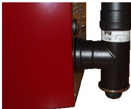
Fig. 34 - Καθαρισμός αγωγού καυσαερίων
