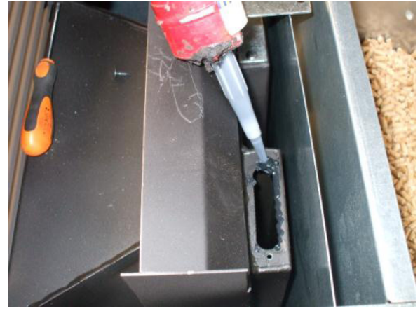
Fig. 41 - Colocação de silicone
