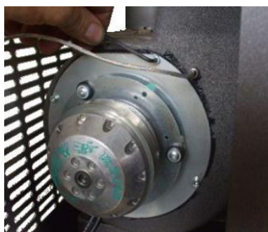
Fig. 35 - Limpeza do aspirador de fumos: fase 1
