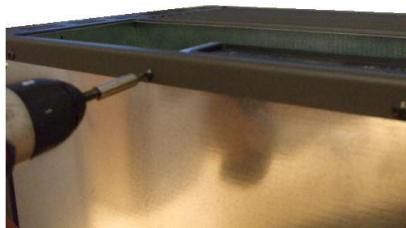
Fig. 15 - Verwijdering schroeven op de achterkant
