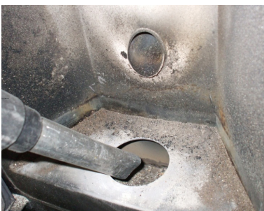
Fig. 28 - Reiniging ruimte vuurpot
