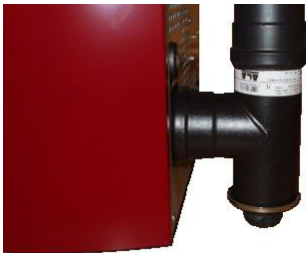
Fig. 34 - Limpeza do canal de fumo
