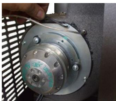
Fig. 35 - Καθαρισμό ανεμιστήρα καυσαερίων : Φάση 1
