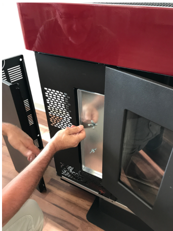
Fig. 72 - De schroeven losdraaien
