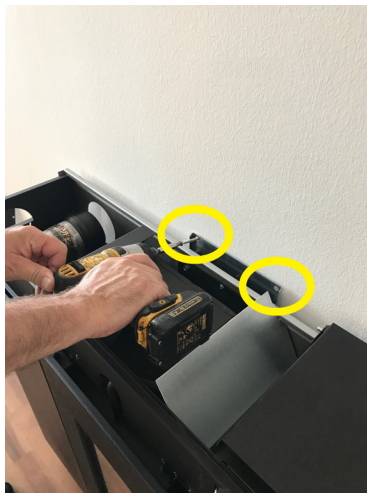
Fig. 23 - Muurbevestiging
