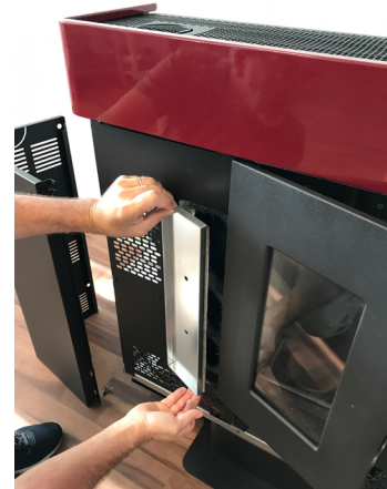
Fig. 73 - Verwijdering van het inspectiepaneel
