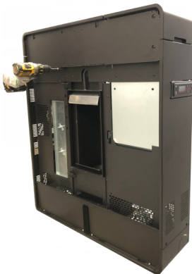
Fig. 33 - Demontage bovenste beugel
